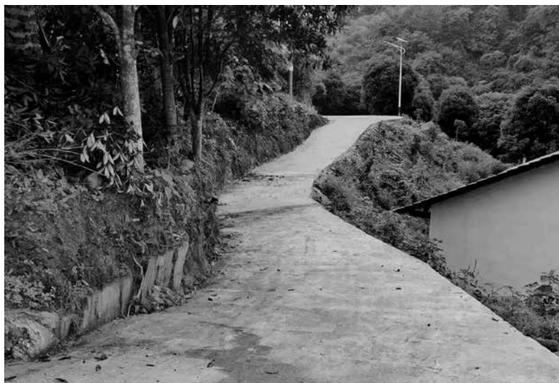
2023 年 10 月 30 日,竣工的蒲芦瑶族乡万全村东岐岭屯内道路硬化和太阳能路灯安装工程
