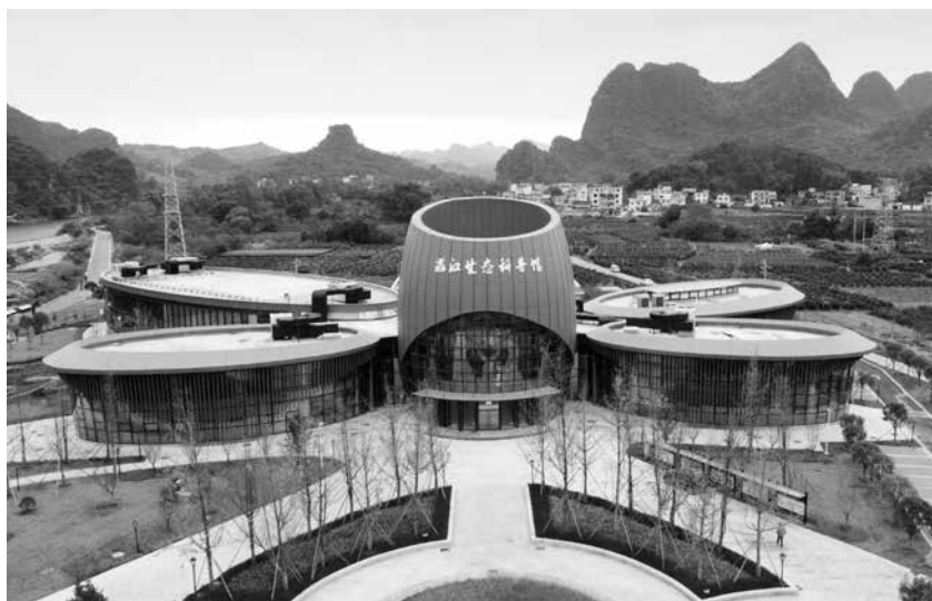
2020 年 10 月,荔江生态科普馆全面竣工投入使用。
